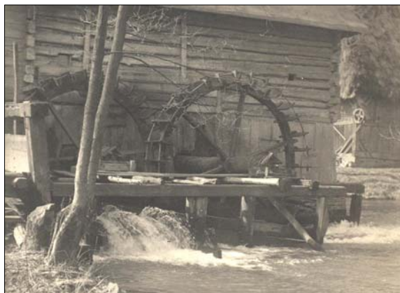
Mlýn Spálenec čp. 186 ve Vysokém Mýtě s vodními koly typu hřebenač. Vpravo transmisní převod hnací síly do stodoly pro pohon hospodářských strojů. Sběrka RMVM, foto autor neznámý, okolo 1935.
